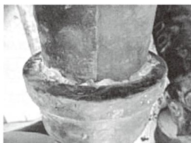
印ろう継手（受け口×挿し口）の接続構造の接合部例
