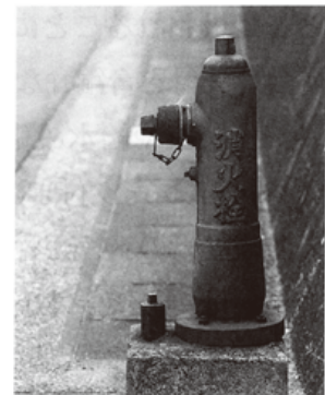
消火栓のある風景
