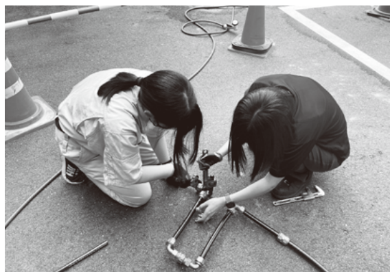
配管体験の様子
